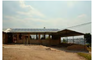
Solaranlage für die Ausbildungsstätte
